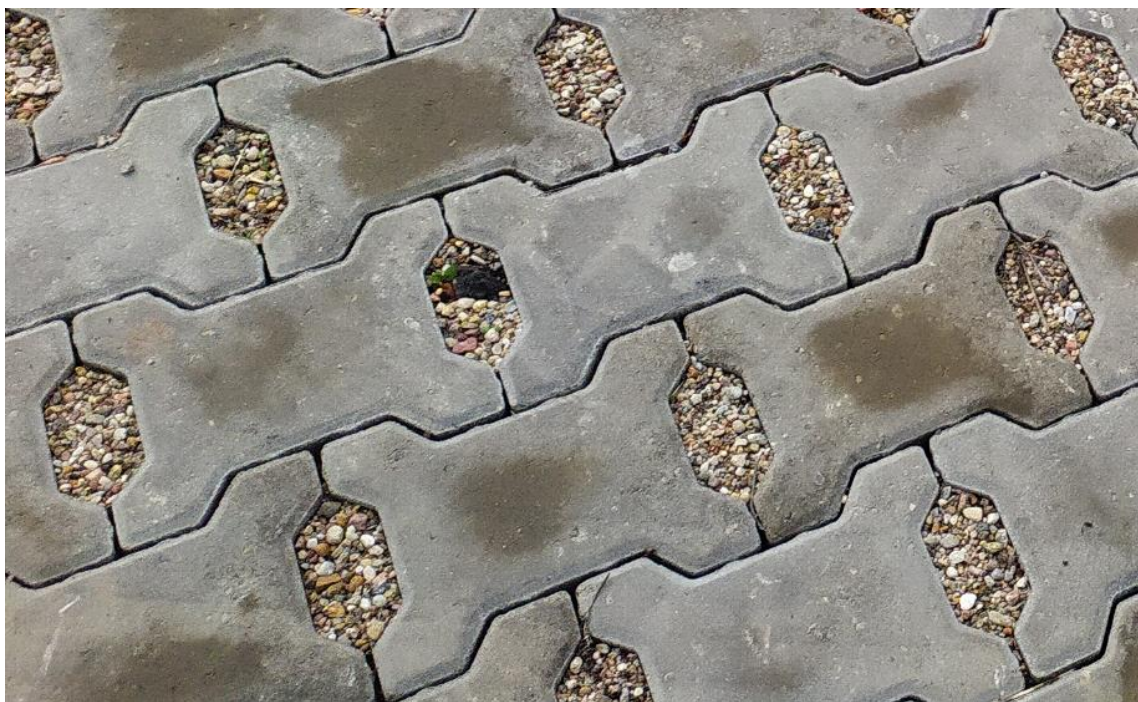
Rys. 4 Sposób ułożenia kostki betonowej EKO BEHATON
